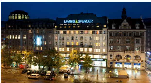
Multifunkční budova Melantrich, Praha
