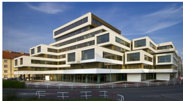
Multifunkční budova Qubix, Praha
