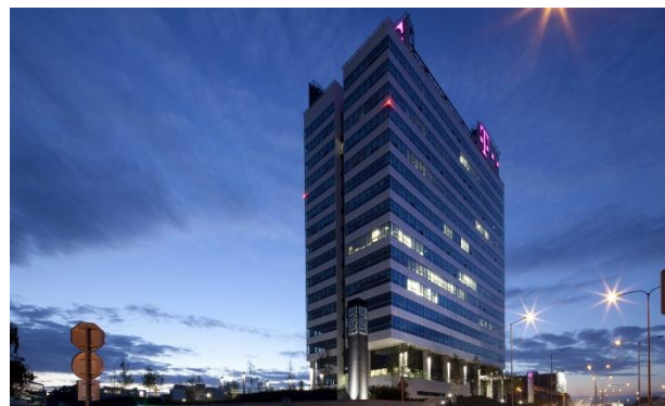
Administrativní budova Forum BC I, Bratislava, SR
