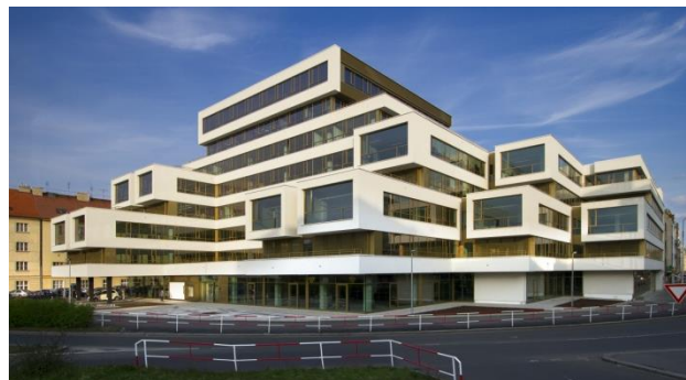
Administrativní budova Qubix, Praha, ČR
