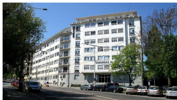
Administrativní budova Táborská 31, Praha, ČR
