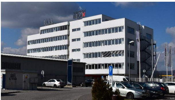
Administrativní; budova Office Box, Bratislava, SR
