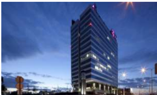
Administrativní budova Forum BC I, Bratislava, SR
