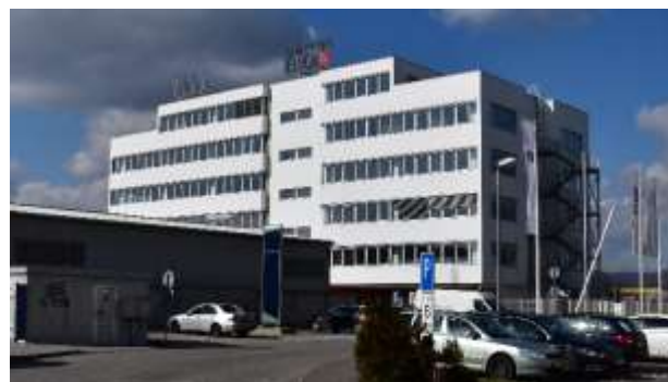
Administrativní; budova Office Box, Bratislava, SR
